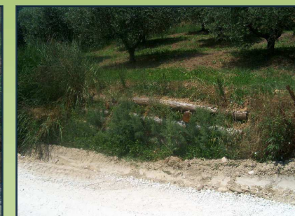
Intervento di IN dopo 6 mesi
