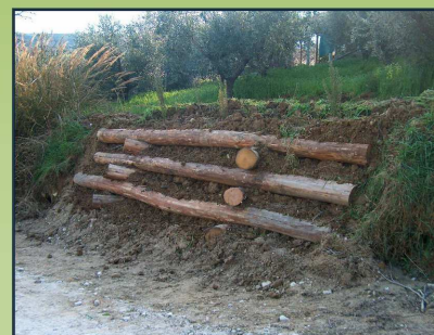
Intervento di IN a fine lavori
