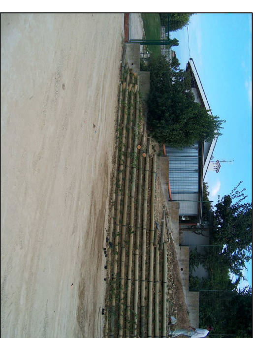
Palificata loricata raccordata con palificata latina
